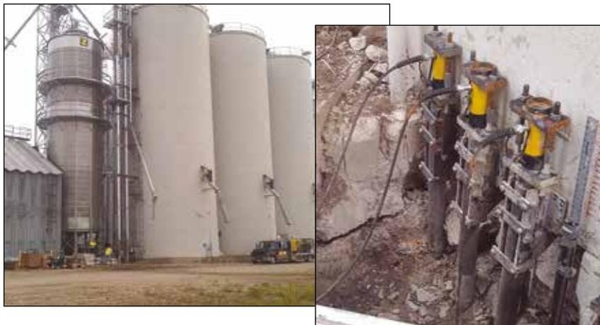
◀ Для ремонта фундамента было необходимо выполнить подъем, выравнивание башен и обеспечить опору их конструкции. К электронасосу серии ZE5 был подключен коллектор-разветвитель, который использовался для приведения в действие нескольких гидравлических цилиндров.
