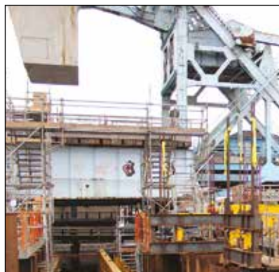
▼ Контролируемая работа 32 высокотоннажных цилиндров Enerpac в ходе постройки нового основания моста.
