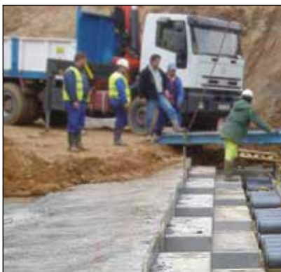
▼ Насосы с разделенным потоком Enerpac используются для перемещения нагрузки домкратами. Чтобы равномерно переместить бетонные элементы конструкции насос серии SFP одновременно приводит в действие длинноходовые цилиндры.
