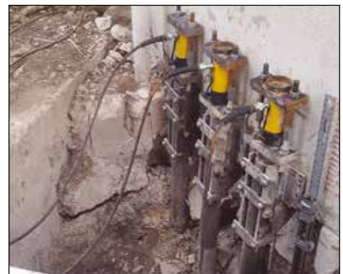
▼ Насос с разделенным потоком используется для приведения в действия нескольких гидравлических цилиндров при ремонте фундамента башни большого диаметра.
