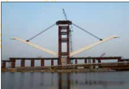
Высокоточный подъем тяжелых конструкций с использованием домкратов
